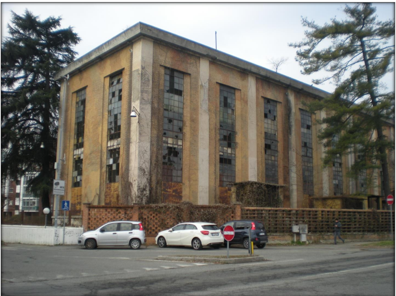
Vista dell'ex sottostazione elettrica FF.SS. dalla Via Torino
