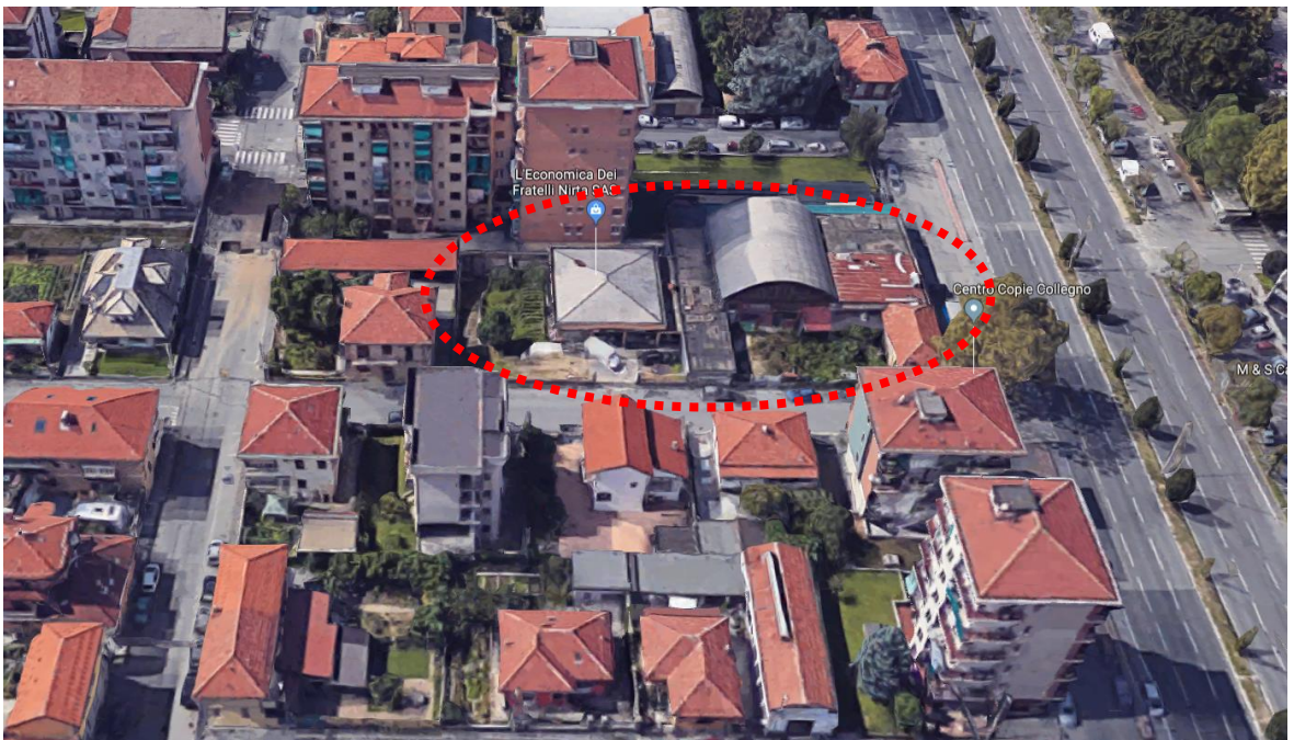
Vista dall'alto dell'area occupata da edifici artigianali
