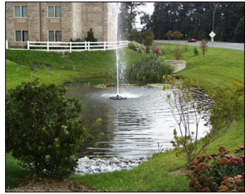
Figura 11. Esempi di bacini di laminazione permanenti a cielo aperto in contesto urbano.
