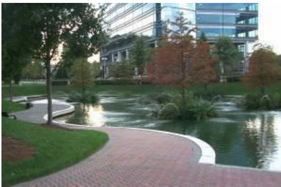
Figura 11. Esempi di bacini di laminazione permanenti a cielo aperto in contesto urbano.
