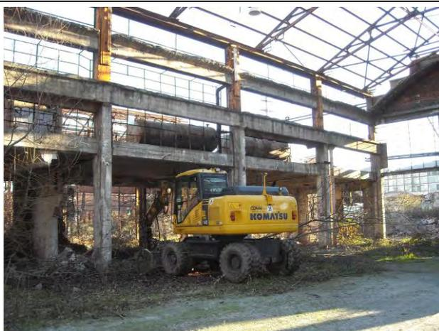
Serbatoi interrati dei gas, rimossi e accatastati sulla copertura del FABBRICATO A
