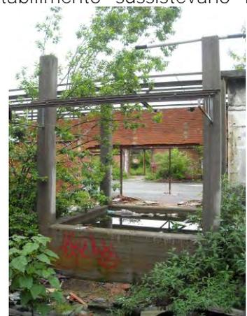
manutenzione. A lato la tettoia proteggeva il deposito degli acidi, conservati in cisterne di plastica da 4 mc poggiate su una base di precontenimento in cls. I pilastri sullo spigolo della vasca sostenevano un impianto di abbattimento dei fumi.
