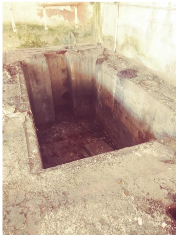
Figura 8. Area Verniciatura, particolare vasca in calcestruzzo
