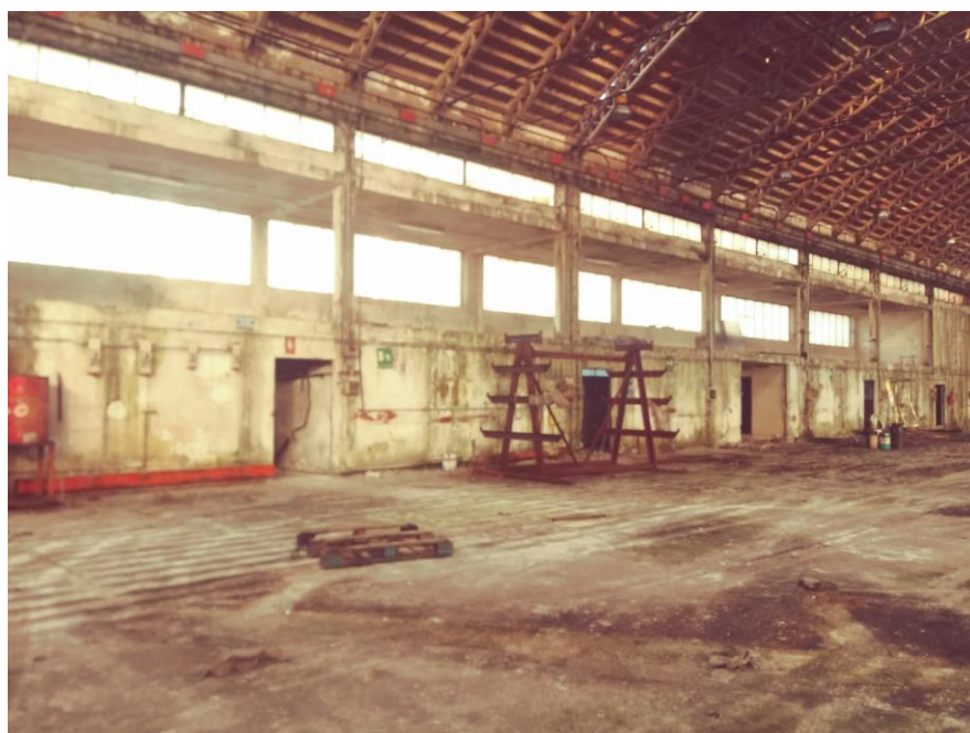
Figura 10. Area lavorazione carpenteria
