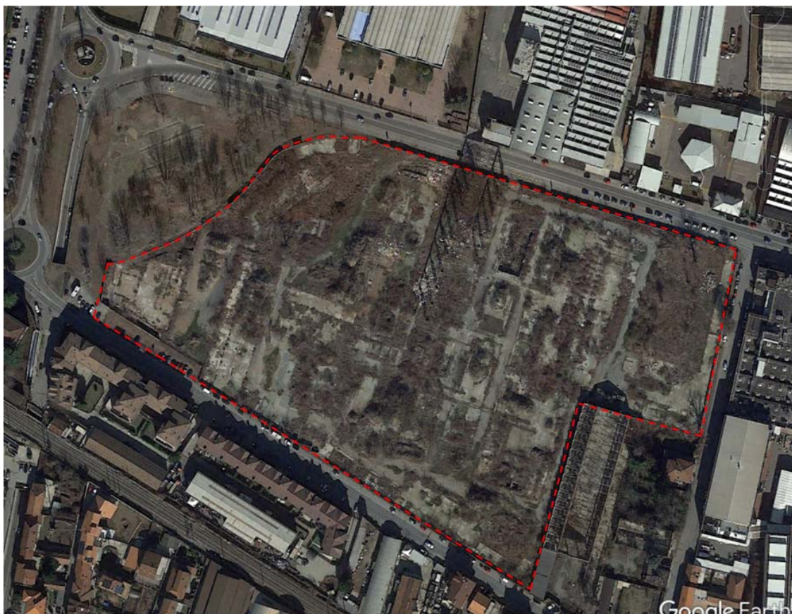
Foto aerea dell'ambito A1 – Villaggio Mandelli: ex acciaierie
