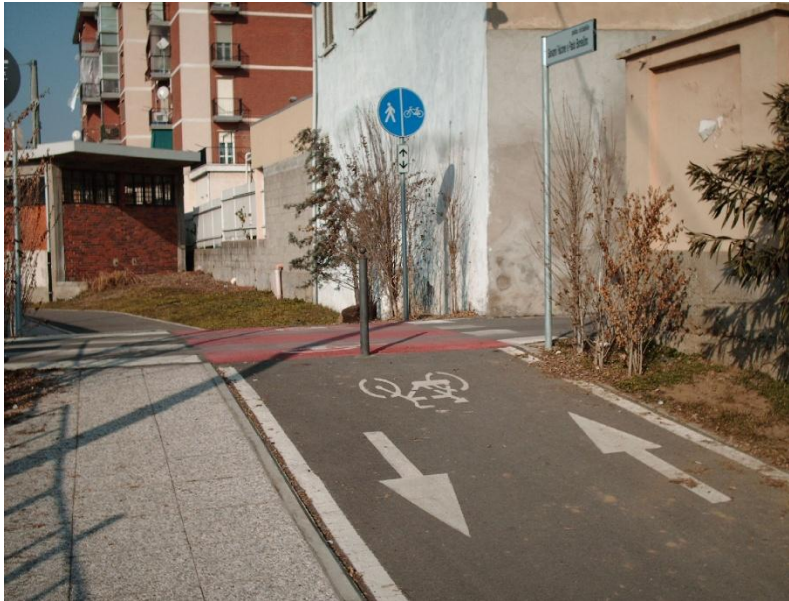
Figura 1 – Pista ciclabile "Falcone e Borsellino" in località Cappuccini – Elementi dissuasori posti agli accessi (Fonte: Progetto IRTECO per la Città di Vercelli)
