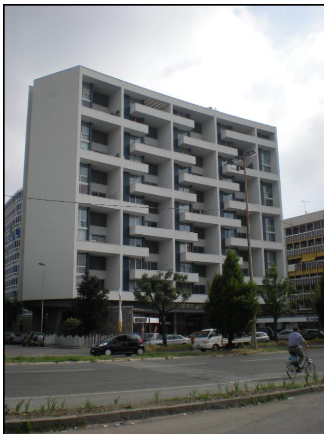
Immagine del fabbricato denominato “Sky” fronteggiante il nuovo edificio.
