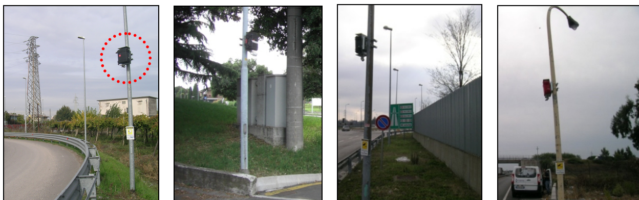
Figura 17 – Esempi di posizionamento delle telecamere ad infrarossi
