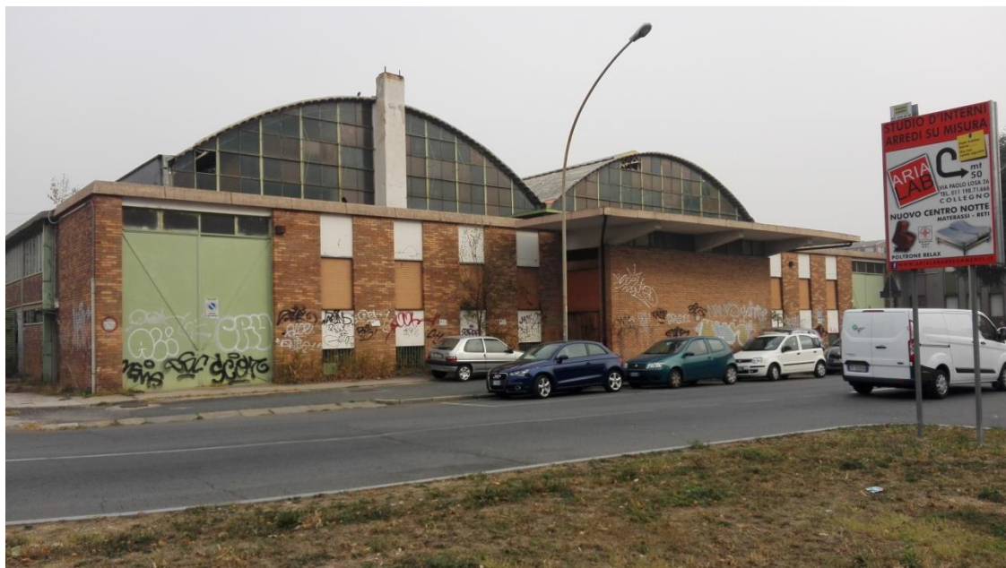
Foto 2 – Fabbricato in dismissione da via De Amicis
