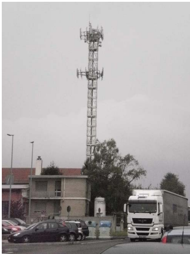
Foto 5.6.4/I Foto del traliccio con le antenne di Via De Amicis
