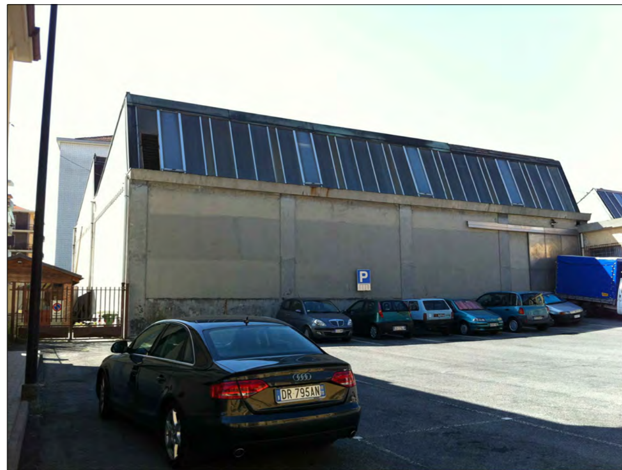
Foto 33. vista nord blocco G
