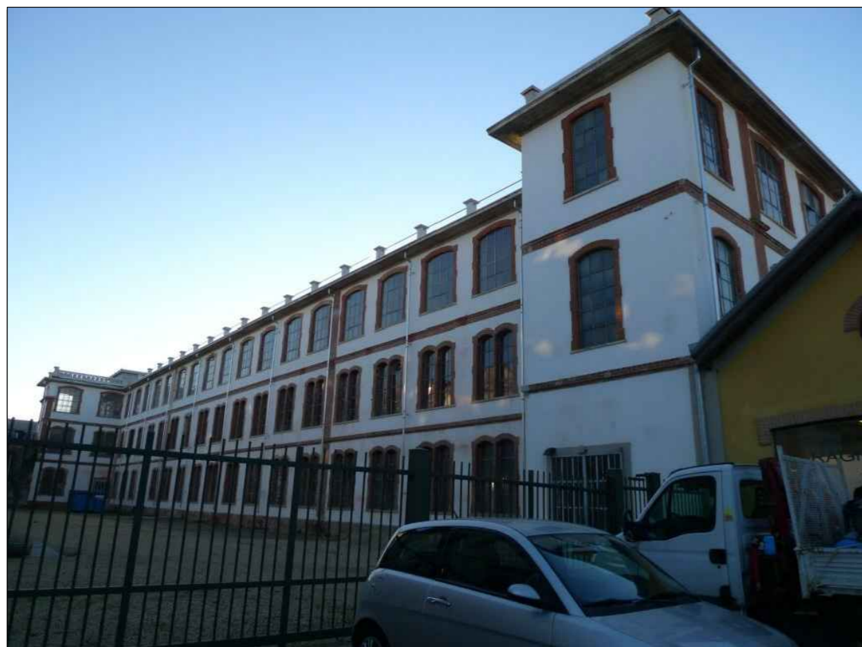
Foto 23. vista nord-est blocchi I-L
