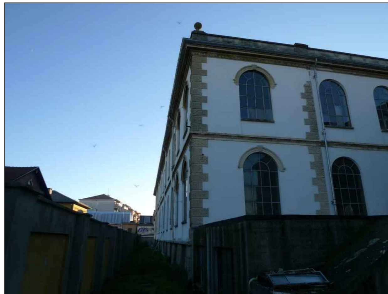
Foto 22. vista nord-est blocco E
