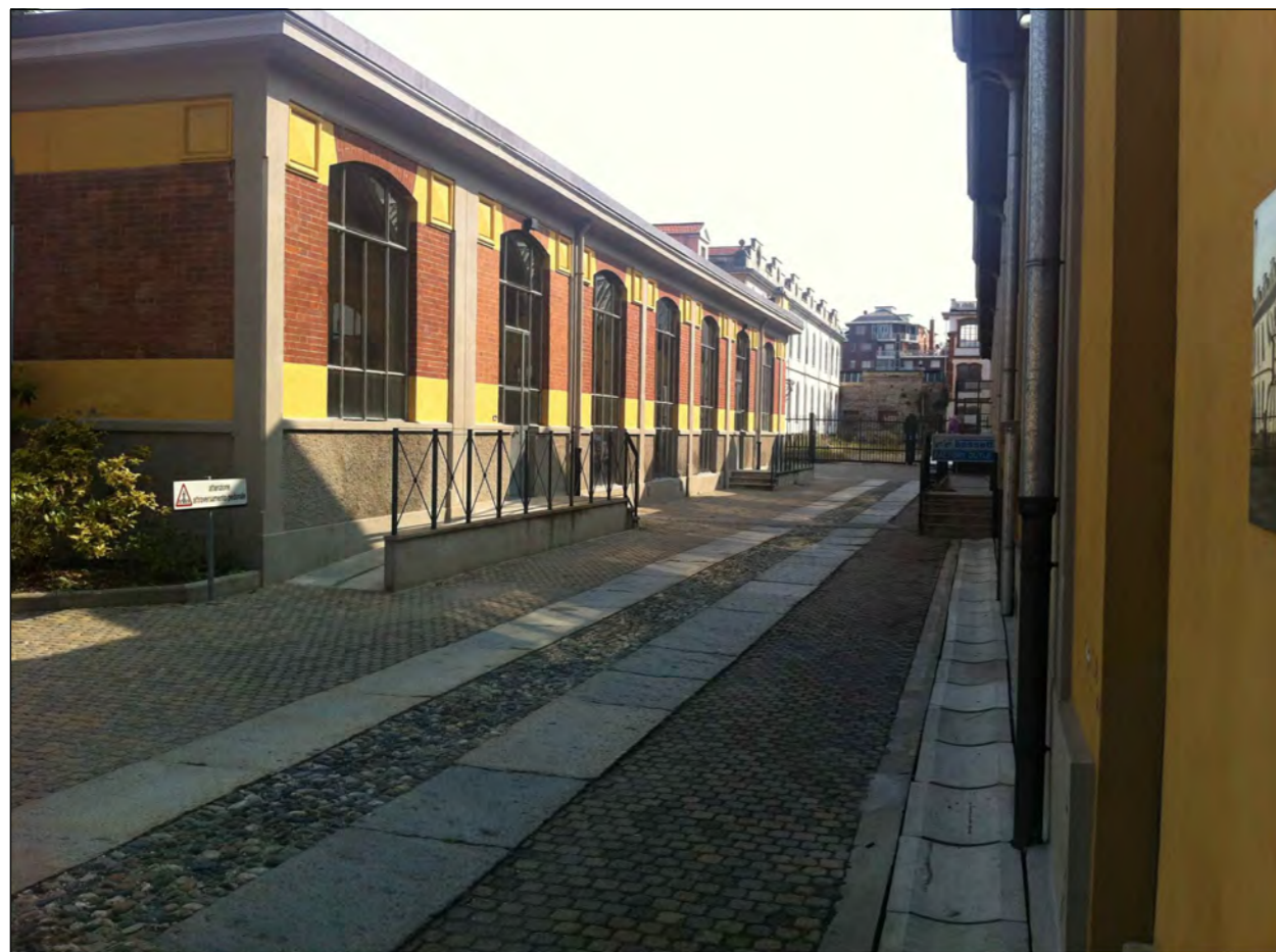
Foto 11. vista viabilità interna - blocco O
