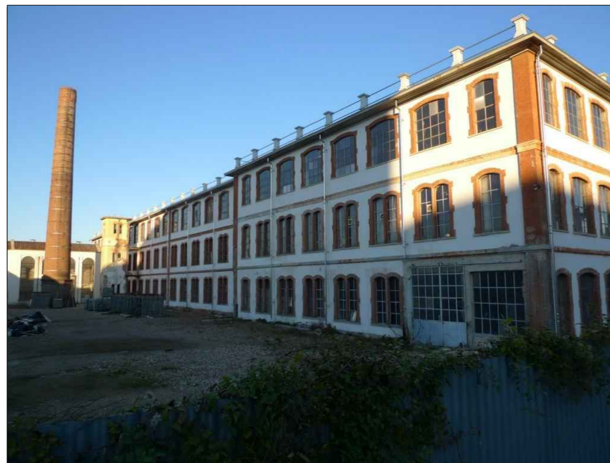
Foto 24. vista sud-ovest blocchi I-L
