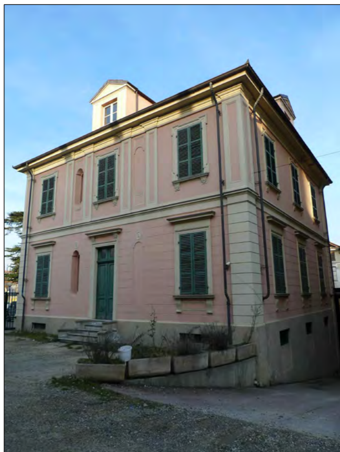
Foto 17. vista blocco D
