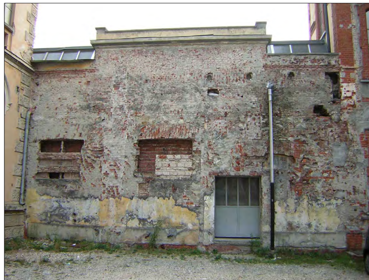
Foto 20. vista porzione blocco F da demolire
