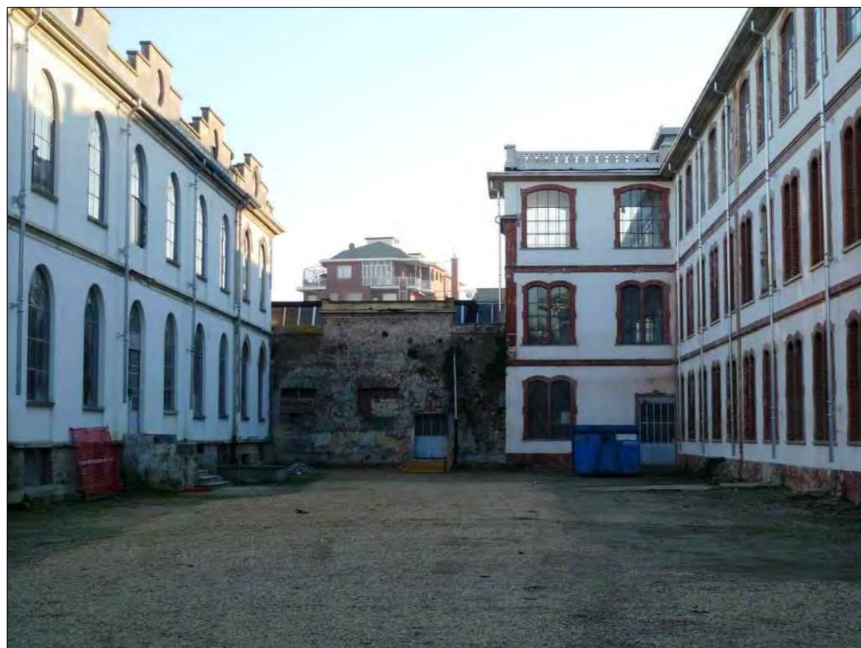
Foto 19. vista cortile interno - blocchi E - F- I
