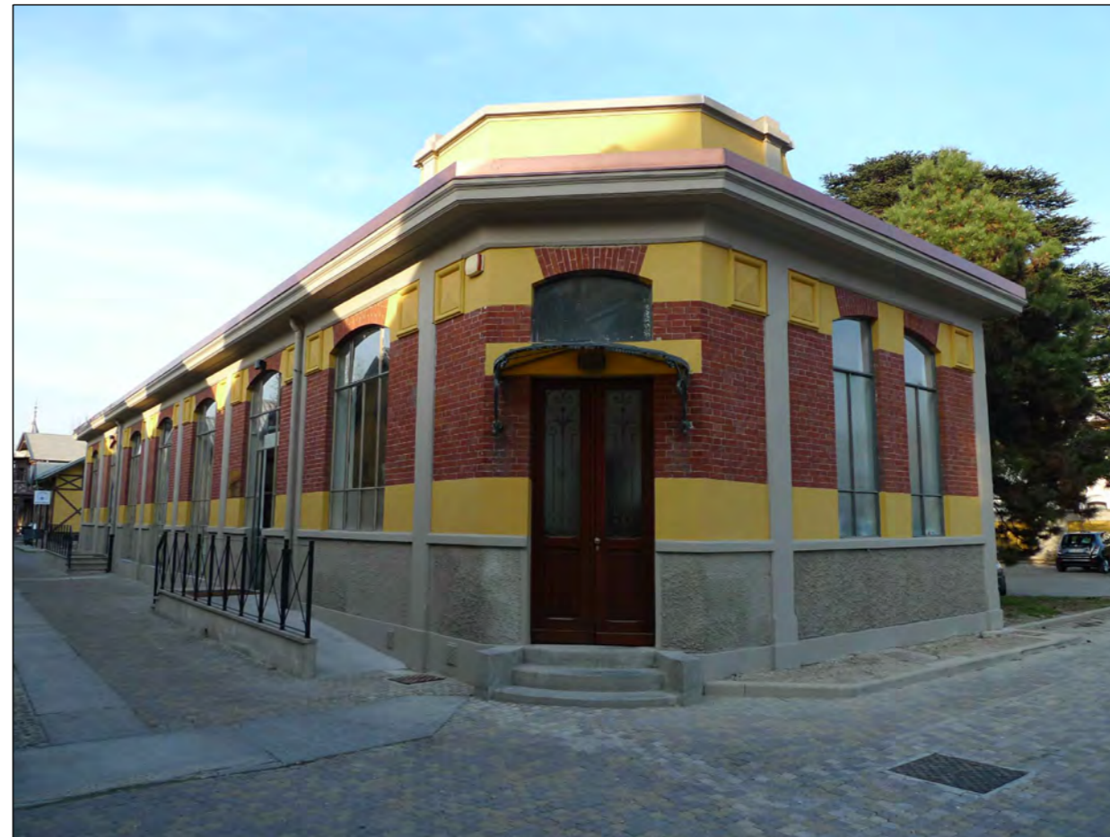
Foto 12. vista blocco O
