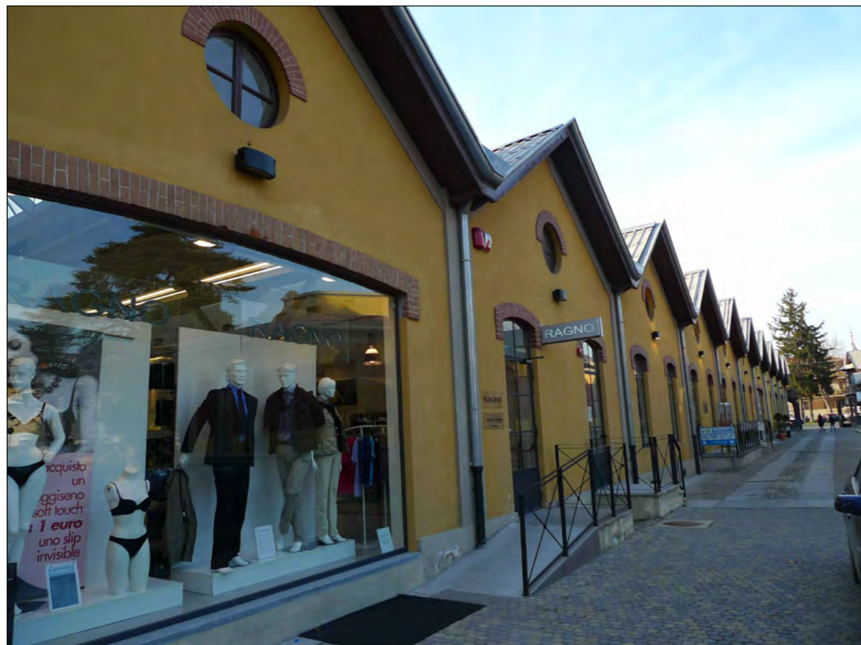
Foto 9. vista blocco N
