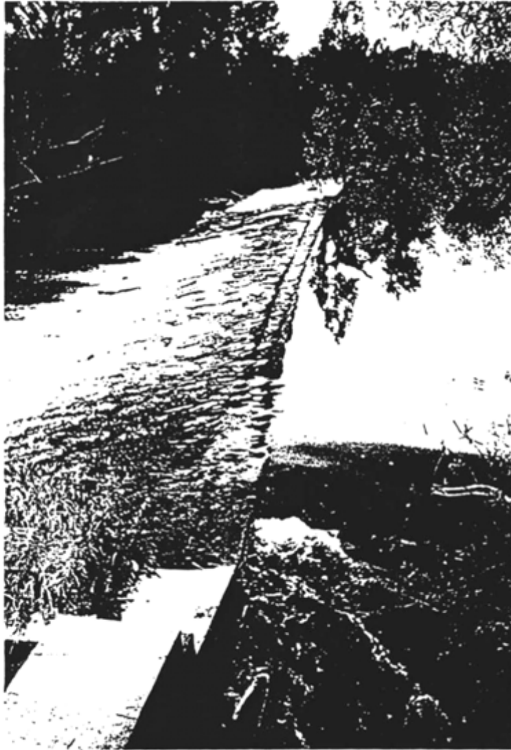
OPERA N° 7: soglia di derivazione idraulica della Bealera Vecchia di Lucento, realizzata circa 600 m a monte di Cascina Ferraris (veduta laterale dalla sponda sinistra).
