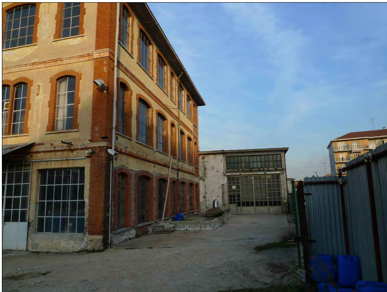
area cortiliva lato via Bargiacchi
