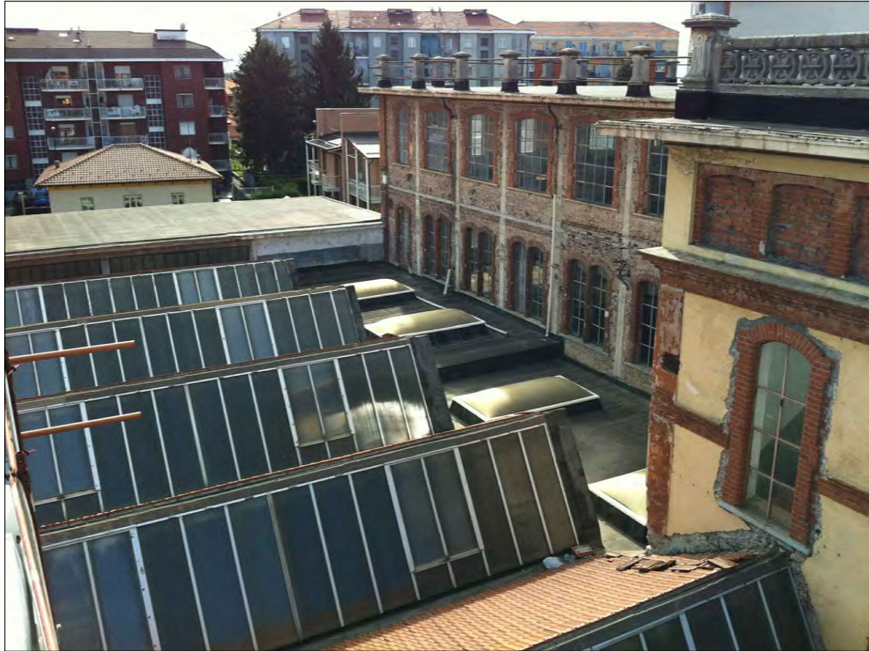
copertura blocco F - lato nord
