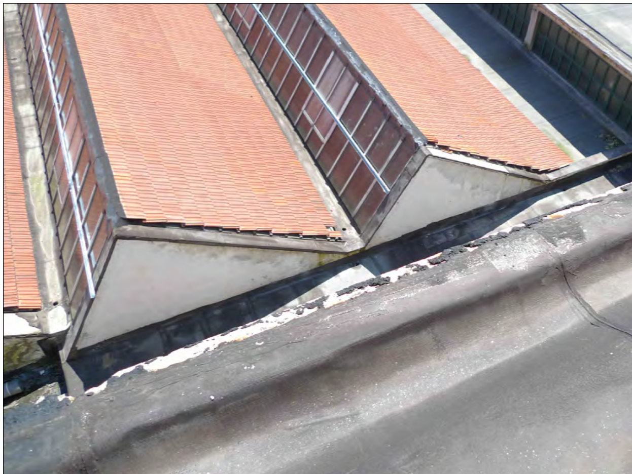
copertura blocco F - lato ovest
