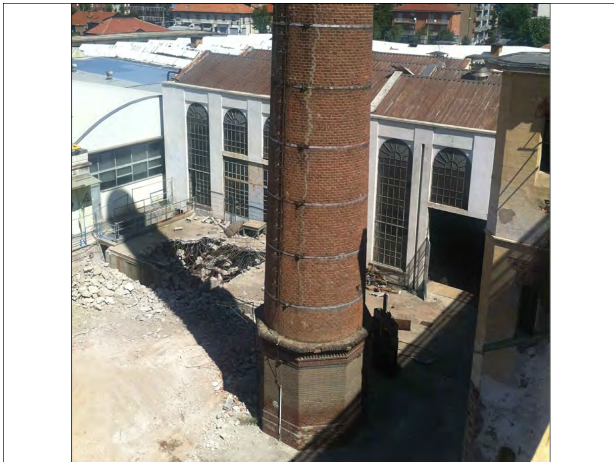
copertura blocco M
