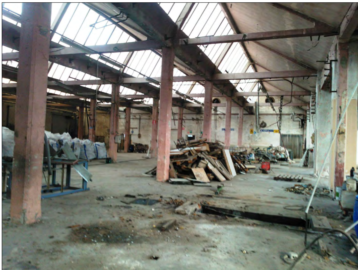
interno blocco F da demolire
