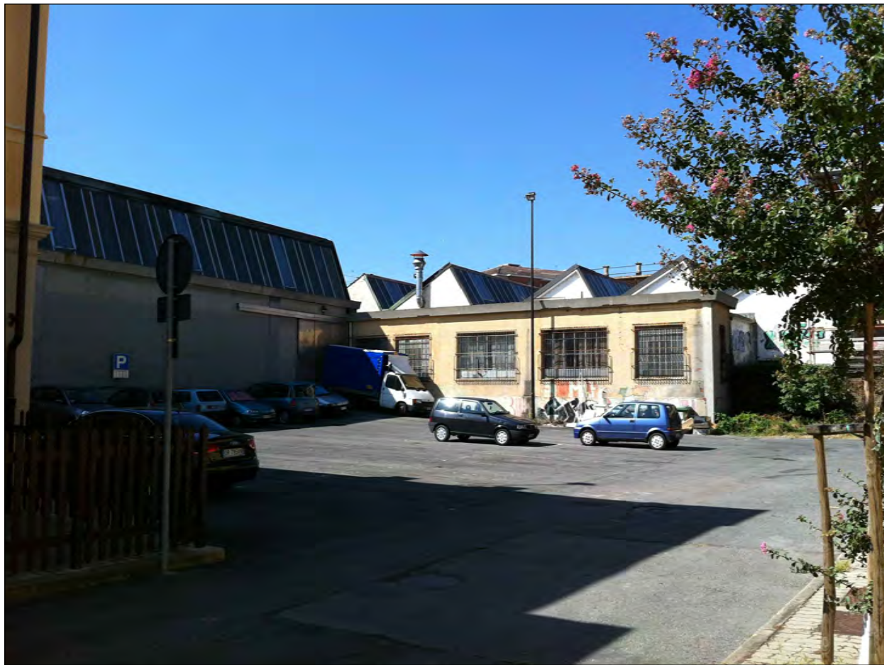
prospetto est su blocco F prima della demolizione
