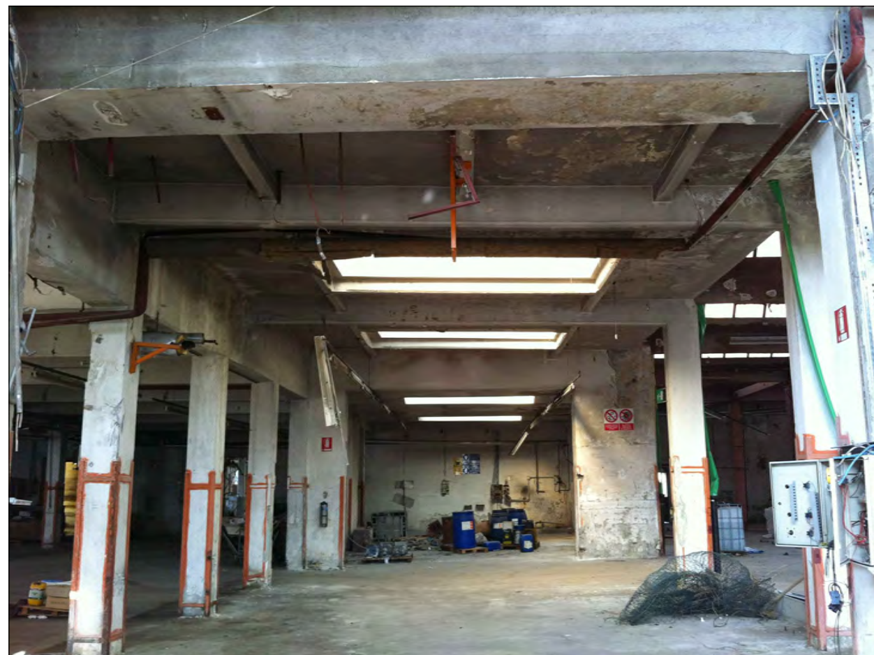
vista interna al blocco F da demolire
