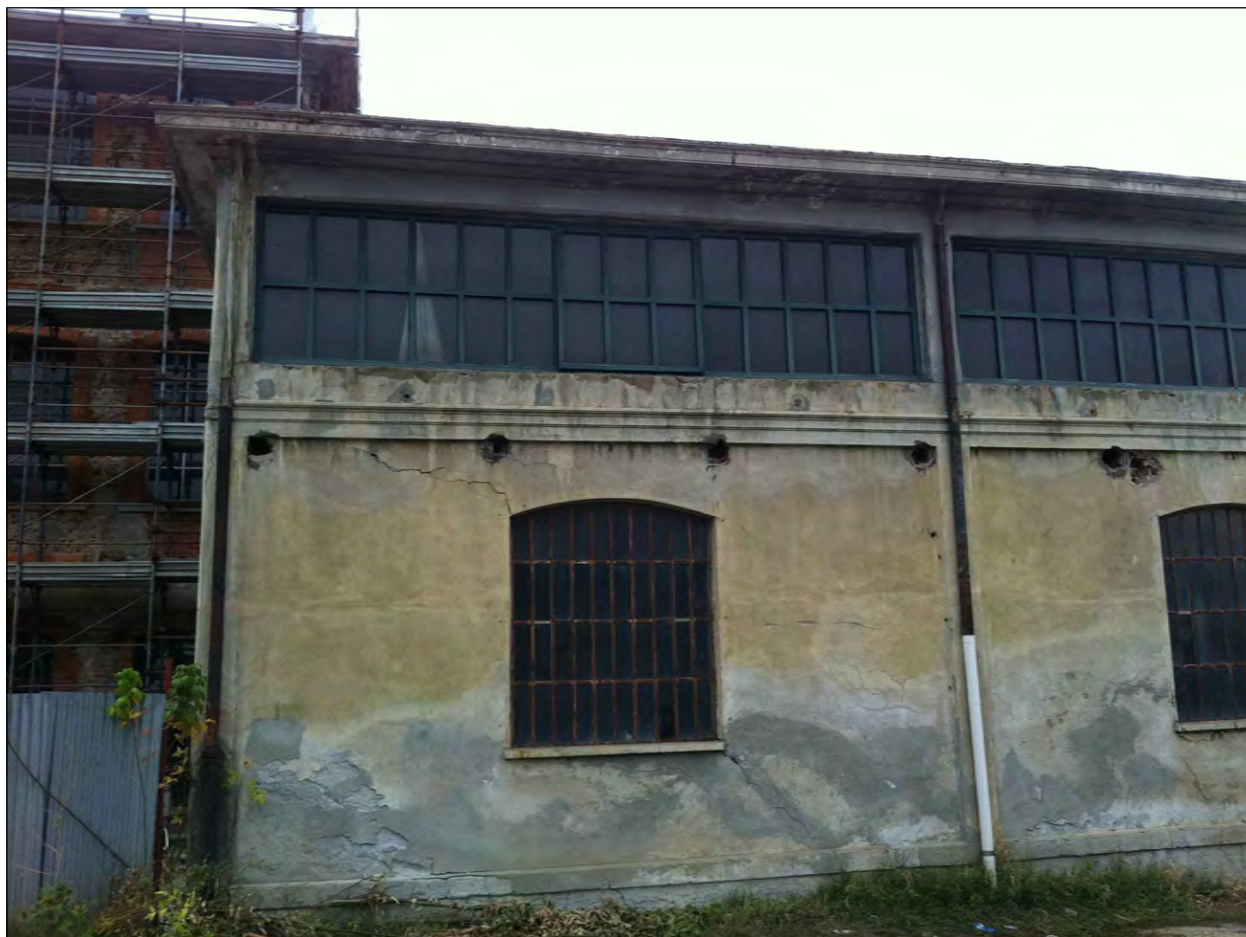
particolare apertura prospetto sud blocco H
