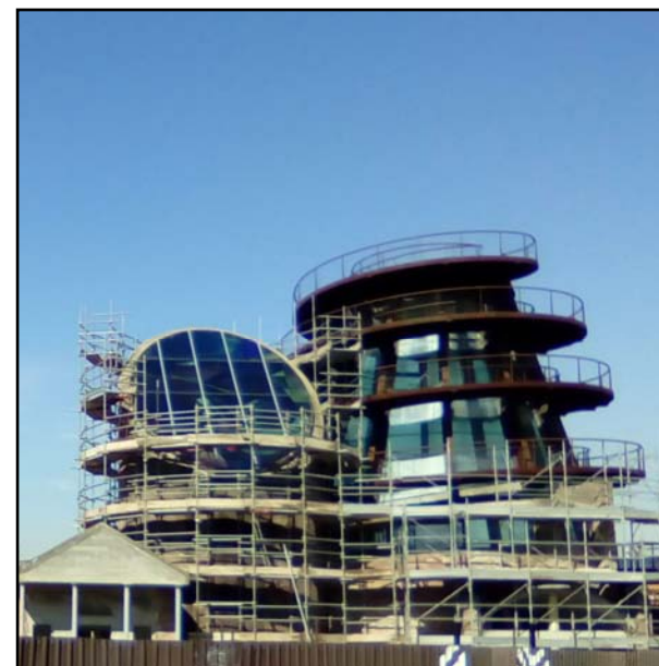
Foto del complesso in costruzione della Clinica della Memoria
