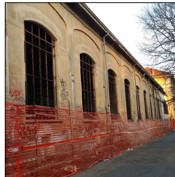
Facciata dell'ex deposito su corso Francia
