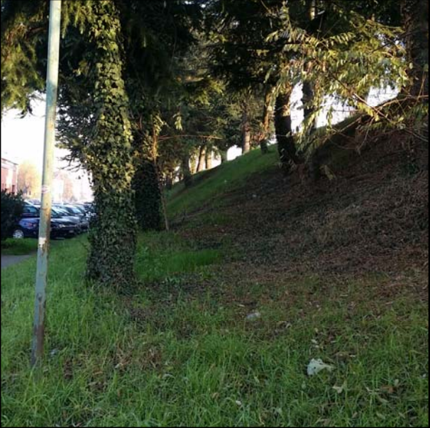
Foto della scarpata lungo via Antonelli
