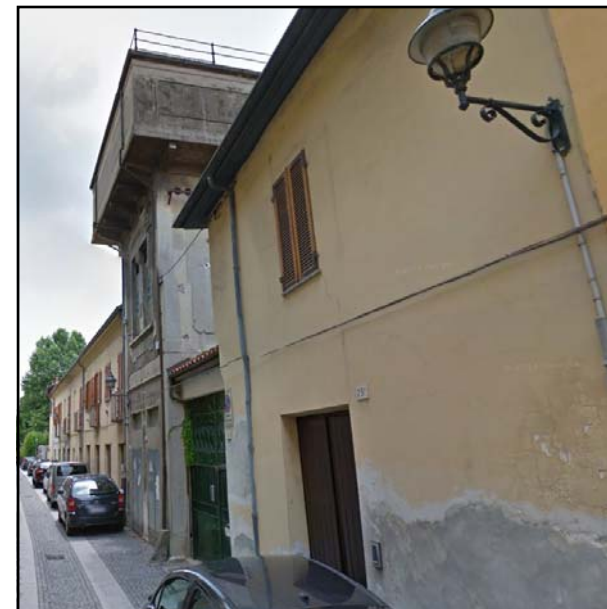
Foto della torre su Via Matteotti
