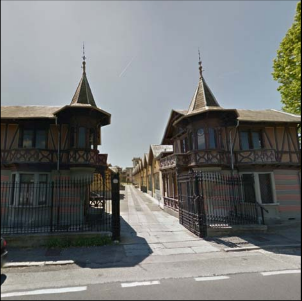
Ingresso dell'ex Opificio Leumann
