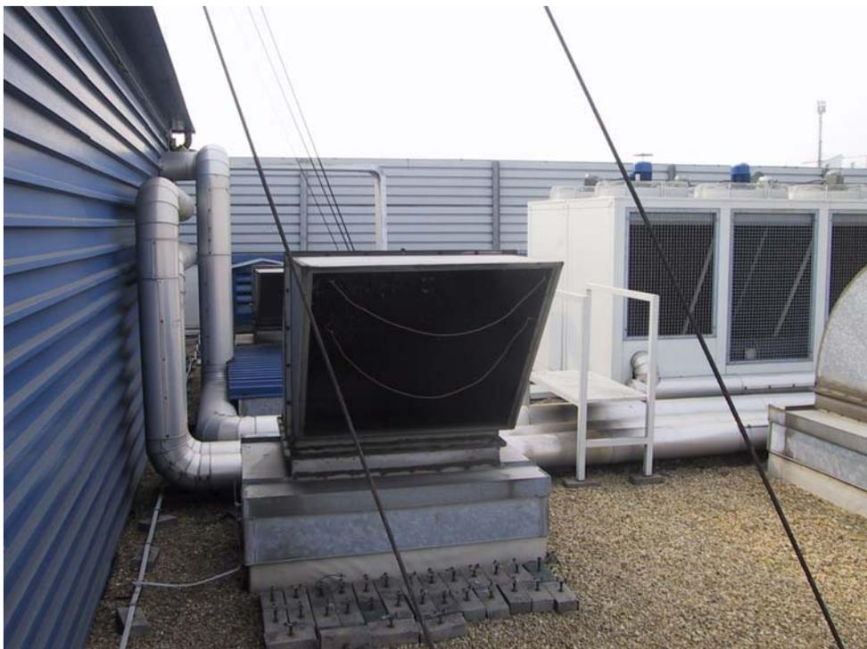
Figura 8: Le prese d'aria delle UTA costituiscono le uniche sorgenti esterne di tipo impiantistico, e così sarà anche nel nuovo sito IKEA di Collegno.
