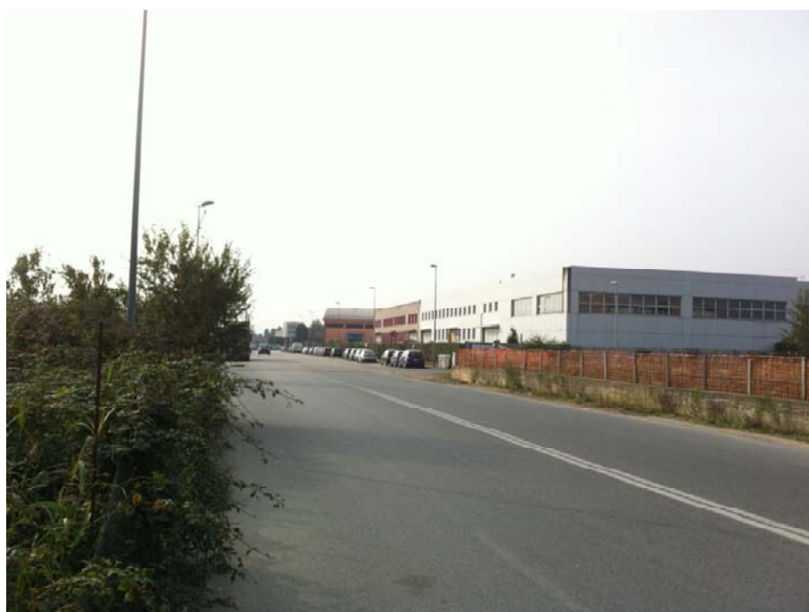
Fabbricati industriali su c.so F.lli Cervi (visti da v.le Certosa)
