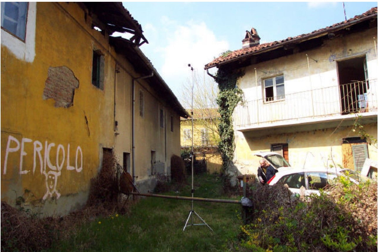
Postazione di misura 2
